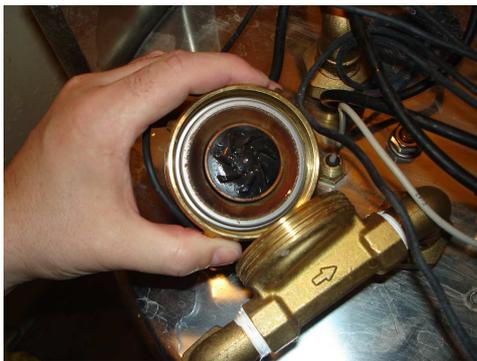
Im Pumpeninneren wird nun die Rotorkugel sichtbar.
